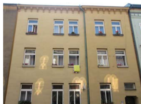
Fasáda BD na ul. Smetanova 234/11 – stav před obnovou (červen 2015)
