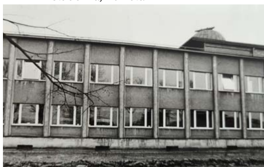
Budova na ul. Ostravská
