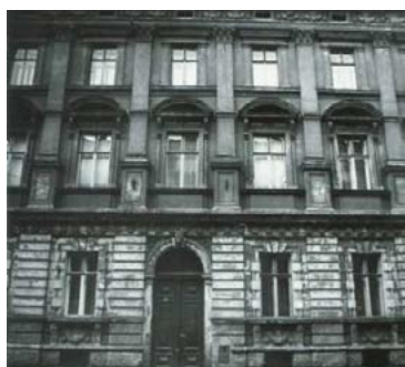
Budova na ul. Pražská
