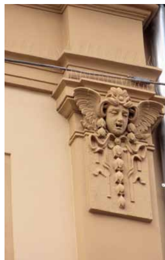
Detail po opravě
