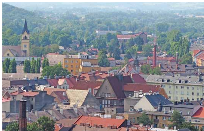
Pohledové uplatnění střechy z Piastovské věže – červenec 2022 – v průběhu prací
