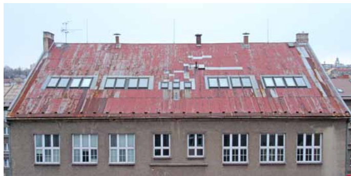
Střecha před výměnou – únor 2022
