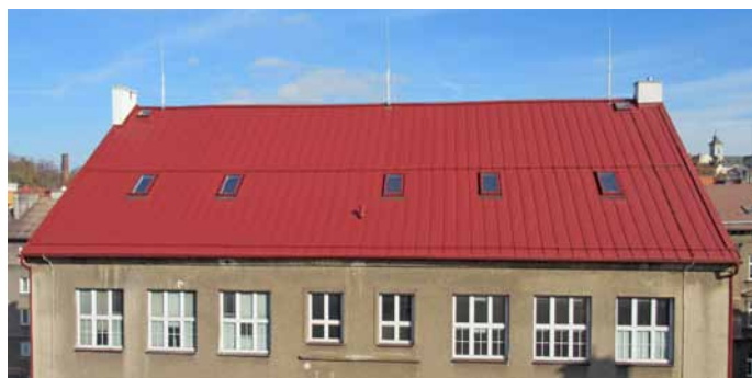
Střecha po výměně – listopad 2022
