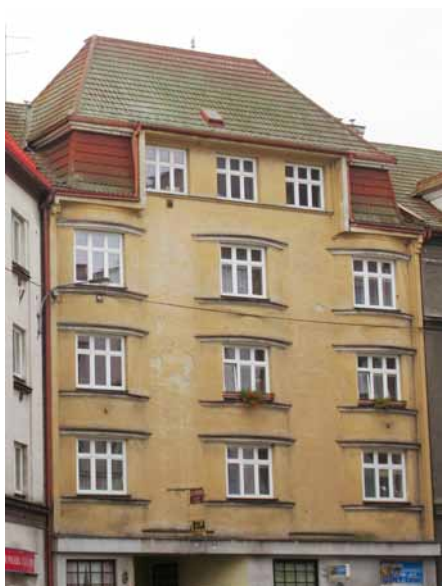
Střecha a uliční fasáda BD na ul. Čapkova 199/9 – stav před obnovou – říjen 2020
