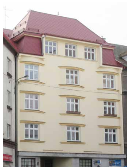
Střecha a uliční fasáda BD na ul. Čapkova 199/9 – stav po obnově – listopad 2022
