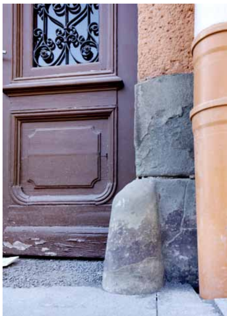
Vyčnívající nárožní kámen u vjezdu na nádvoří, který měl za úkol zabránit poškození budovy projíždějícími povozy. Foto | Czesław Kraina
