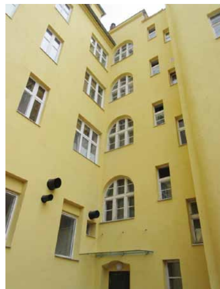
Dvorní fasáda BD na ul. Nádražní 206/16 – stav po obnově – září 2022
