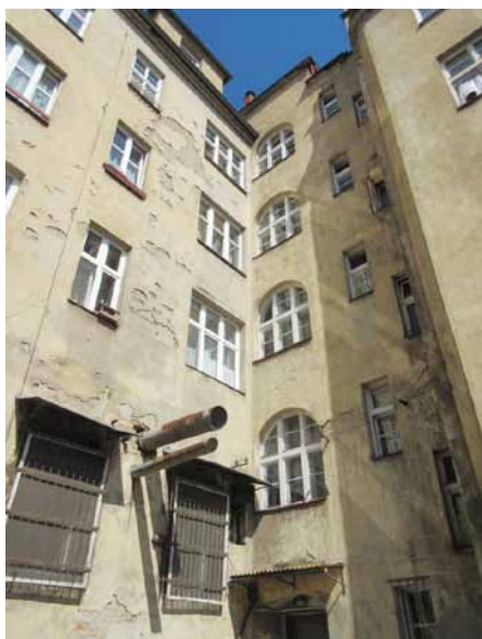
Dvorní fasáda BD na ul. Nádražní 206/16 – stav před obnovou – květen 2022
