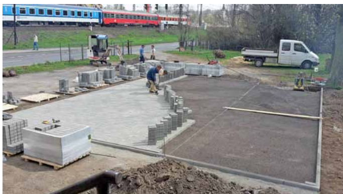
Stavba zahradní restaurace, foto PP
