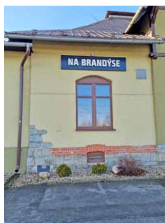
Původní základy restaurace zůstaly zachovány, foto vlastní
