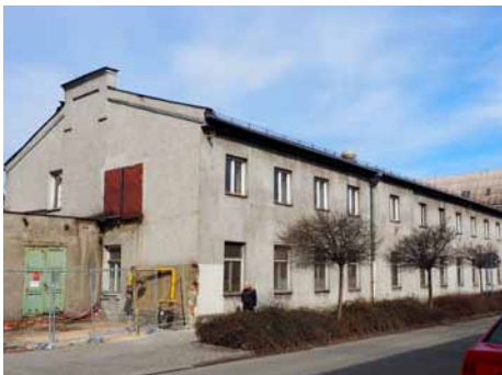
Průjezd do dvora od ul. Střelniční – stav před konverzí – duben 2018
