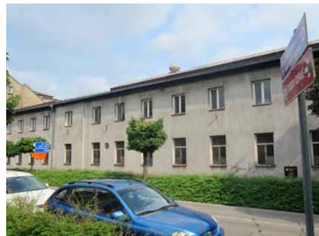
Průčelí od ul. Střelniční – stav před konverzí – červen 2015
