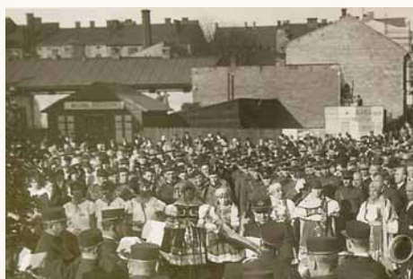
Pohled z Radničního náměstí na nezastavěnou stavební parcelu na rohu s ul. Odboje. V levé části fotografie je patrný kiosk, který musel ustoupit družstevnímu domu. Kolem roku 1929. Foto | Státní okresní archiv Karviná
