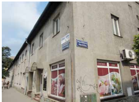
Nároží ul. Střelniční a Havlíčkova – stav před konverzí – červen 2015
