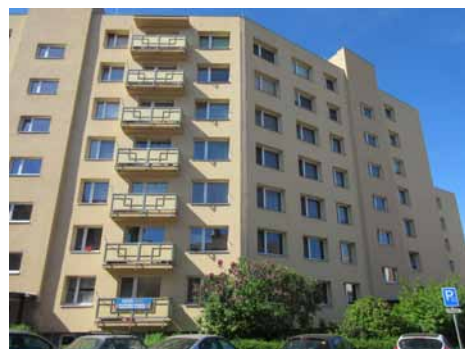
Blok tří domů na ul. Viaduktová a S. Tůmy – stav po zateplení – květen 2022
