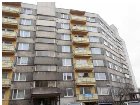
Blok tří domů na ul. Viaduktová a S. Tůmy – stav před zateplením – únor 2020
