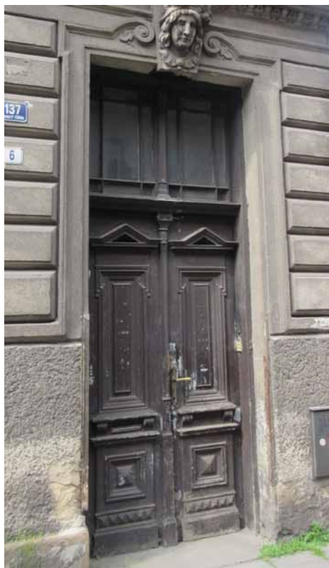
Dveře BD na ul. Božkova 137/6 – stav před obnovou – červen 2015
