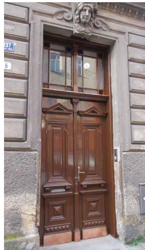
Dveře BD na ul. Božkova 137/6 – stav po obnově – listopad 2020
