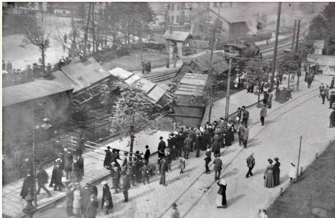
2. října 1913 vykolejil u Demlova podchodu nákladní vlak. Důvodem byly nedotažené šrouby kolejových podkladnic a shnilé pražce. Foto | Soukromá sbírka Czesława Krainy
