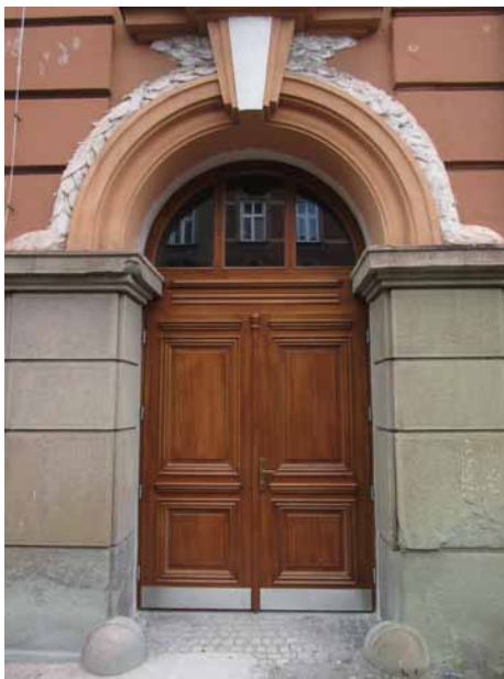
ZUŠ – stav po výměně dveří – červenec 2020
