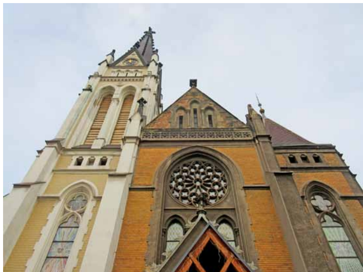
Kostel NSJ – stav před opravou – leden 2020
