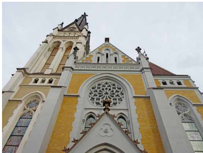
Kostel NSJ – stav po opravě – listopad 2021
