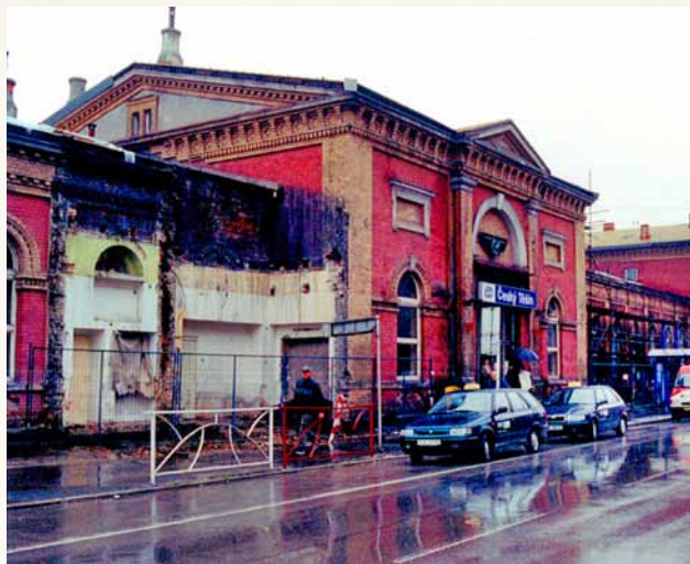
V letech 2001-2002 probíhala generální rekonstrukce výpravní budovy, během které byly ubourány přístavby z let před 1. světovou válkou. Foto | Soukromá sbírka Czesława Krainy
