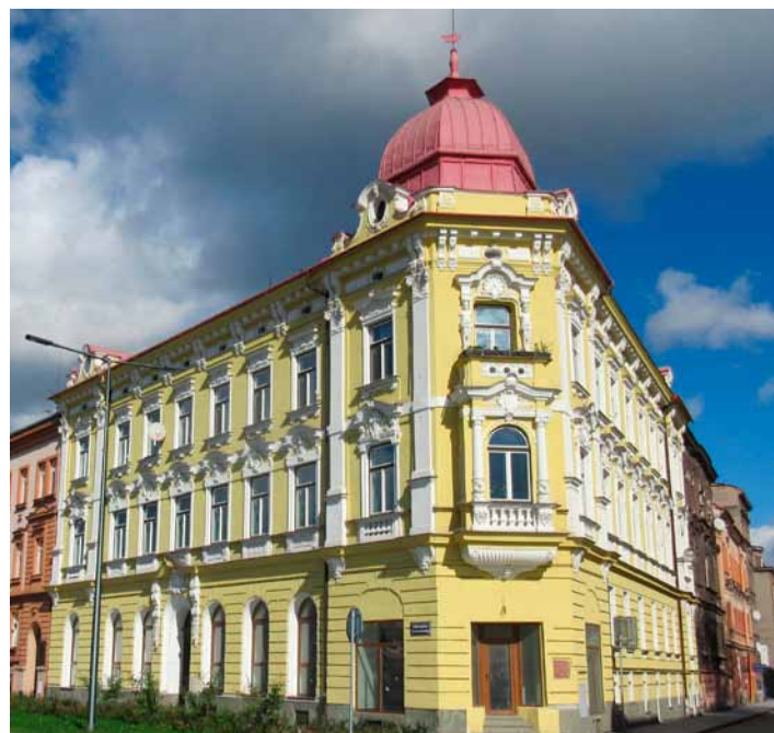
Bytový dům po opravě – říjen 2022
