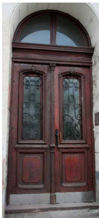
Původní vstupní dveře do bytového domu
