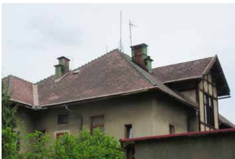
Střecha před výměnou – květen 2021
