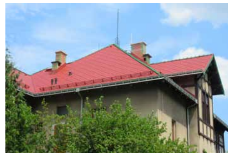
Střecha po výměně – červen 2022
