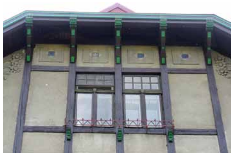
Osazené repliky vzpěr v hrázdění nad oknem a jejich obnovená barevnost
