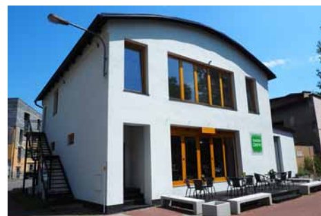
Bývalá SAUNA – stav po provedení prací – červenec 2022
