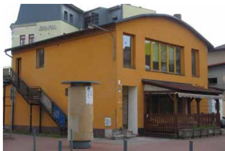
Bývalá SAUNA – stav před rekonstrukcí – duben 2021
