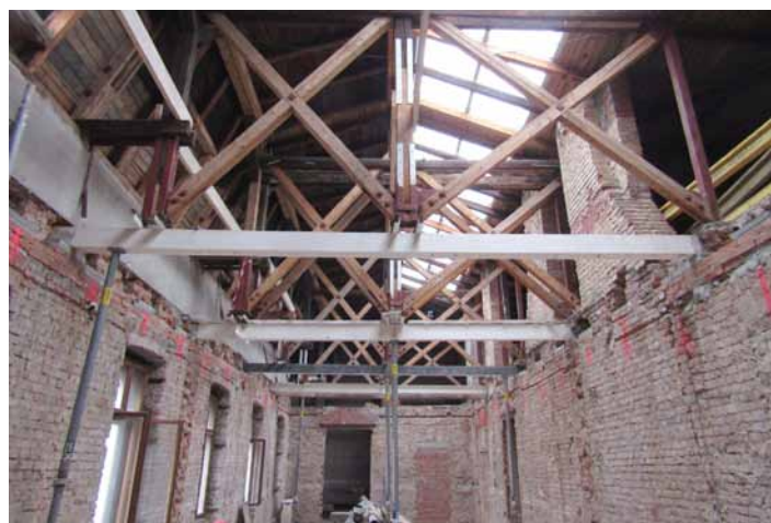
Rekonstrukce Historické budovy na Hlavní třídě
