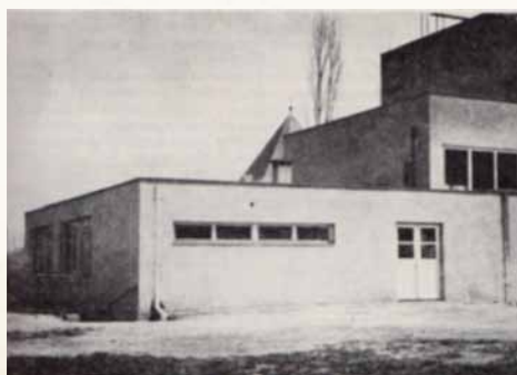
Školní dílna, stavba v akci Z, rok 1959.
