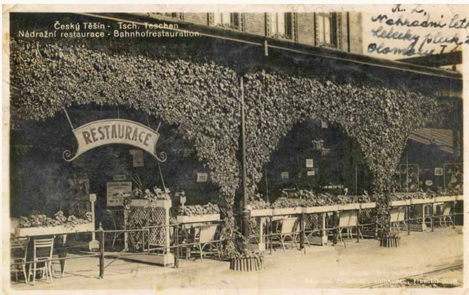
V důsledku zrušení zahradní restaurace byla jako náhrada otevřena restaurace přímo na nástupišti. Kolem roku 1930. Foto | Soukromá sbírka Czesława Krainy
