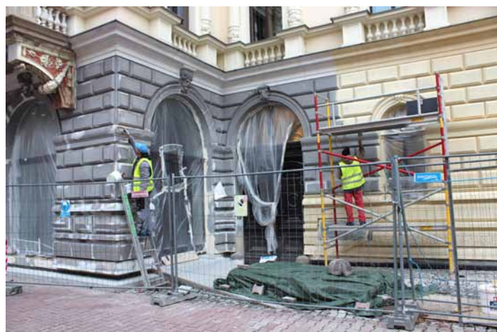
Nátěr fasády rekonstruované muzejní budovy
