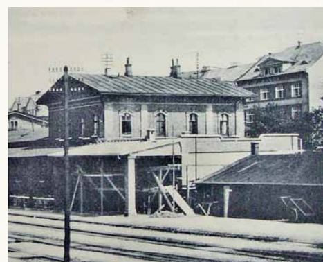
Tři pohledy z železniční lávky na prostranství, které se během let několikrát změnilo. Nejříve zahradní restaurace, následně celní budova a nakonec přístavba revizní místnosti. Foto | Soukromá sbírka Czesława Krainy
