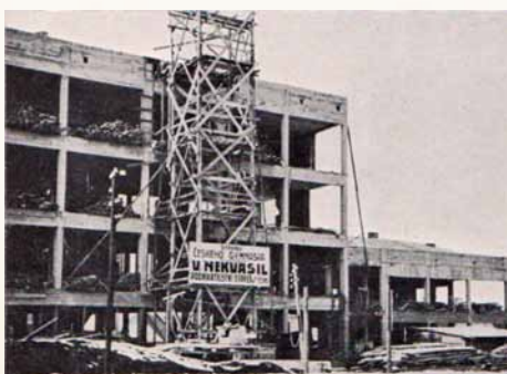
Výstavba nové školní budovy.
