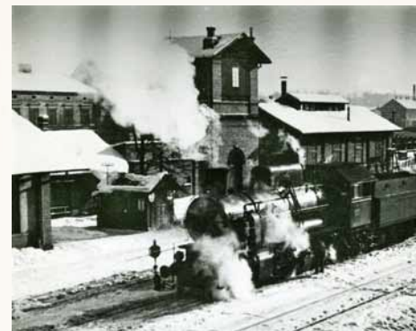
Pohled z železniční lávky na budku signalisty, v pozadí mechanické dílny, chlév, vodárenská stanice a výtopna. 30. léta 20. století. Foto | Koleje Śląska Cieszyńskiego
