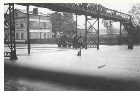
Přechodová lávka na fotografii pořízené během povodně z 31. května 1940, která zaplavila mezi jinými vlakové nádraží. Foto | Státní okresní archiv Karviná
