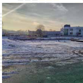
Stavba dopravního terminálu začala Strana 2
