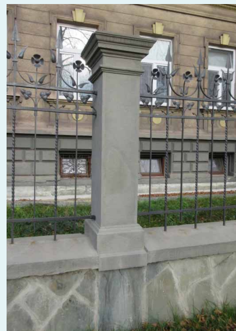
Plot po obnově
