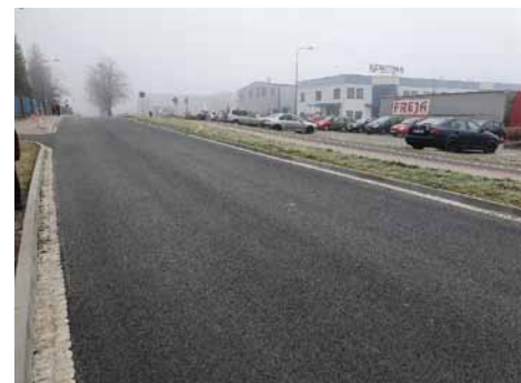
Dokončení projektu Zabezpečení dopravní obslužnosti průmyslové zóny
