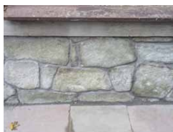
Střelníční – bývalá plynárna před a po opravě soklu
