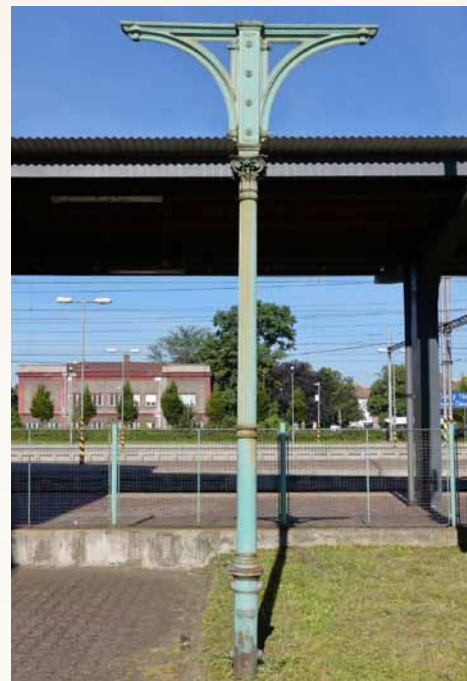
Po dávném přístřešku zůstal pouze litinový sloup podpírající ocelovou konstrukci zastřešení vchodu na nástupiště. Foto | Czesław Kraina
