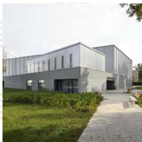
V soutěži Stavba MSK vítězí i naše projekty
