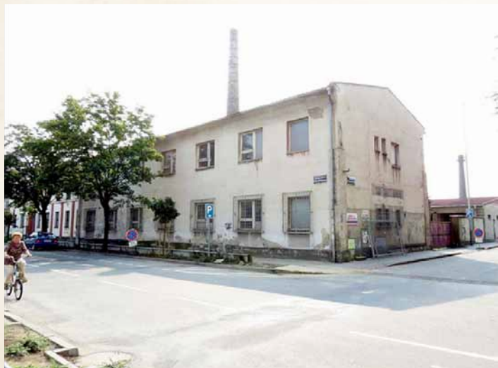
Budova plynárny v roce 2012, zdroj: Josef Pinter
