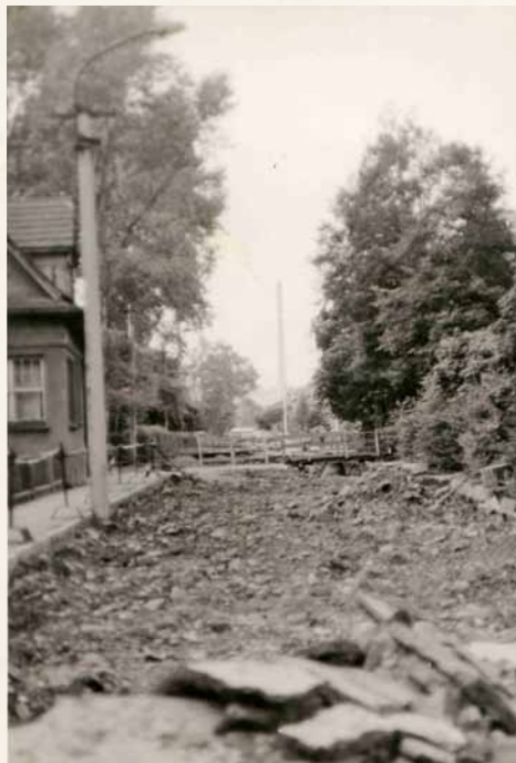
Cca 1970 - 1975 rekonstrukce kanalizace Tyršova ulice. Autor: M. Macura
