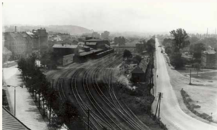
Stanice Český Těšín, pohled na bohumínské zhlaví nalevo Nádražní ul. napravo Jablunkovská. Rok 1936-1938 zdroj czesil.
