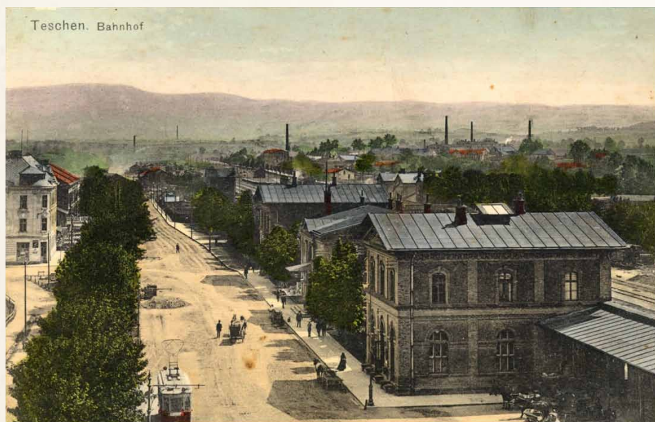
1900 pohled z železniční lávky na nádraží / zdroj: Fotopolska
