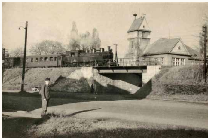
1950 viadukt na Karvinské ulici / Zdroj: Fotopolska
