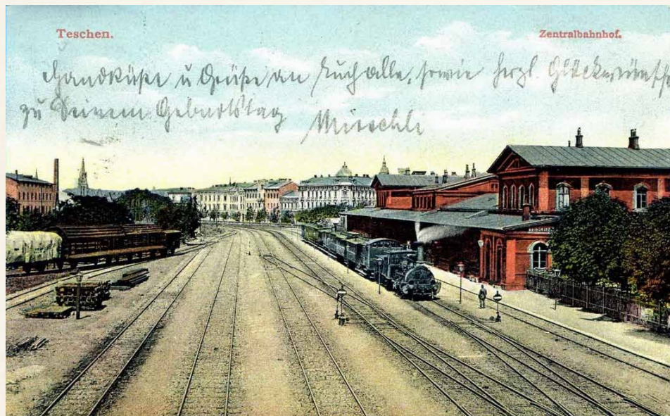
1900 pohled z železniční lávky na nádraží zdroj Fotopolska
