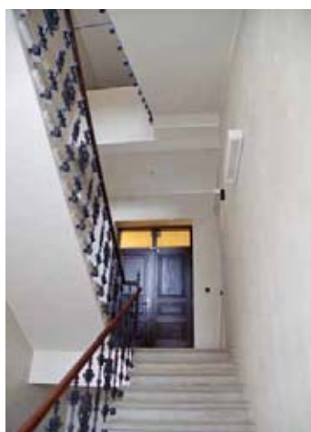
Schodiště jsou po opravě k nepoznání.
