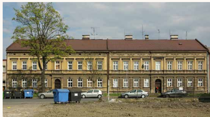
Současný pohled na činžovní dvojdom, který vznikl přestavbou Kukuczova skladiště. Foto | Czesław Kraina
