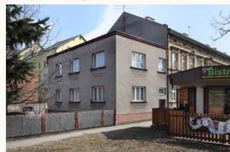
Současný pohled na budovu dávne dílny bratrů Arbanových, která byla v roce 1977 přestavěna do nynější podoby. Foto | Czesław Kraina
