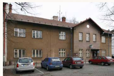
Pohled z roku 2011 na dům Antona Jonkische, který sloužil Severní dráze císaře Ferdinanda. Foto | Czesław Kraina
