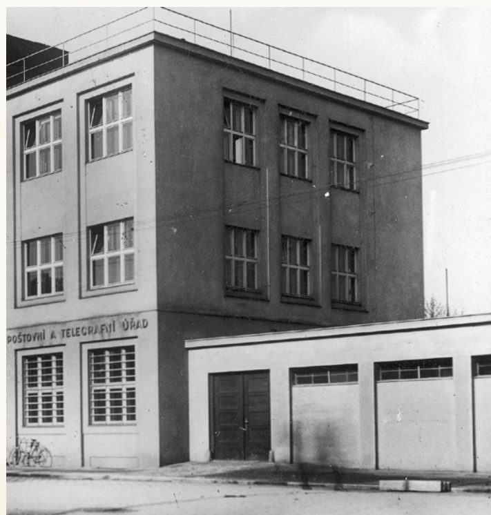
Pohled z roku 1936 na dnes již neexistující přízemní objekt, ve kterém se nacházela kůlna a skladovací dvůr. Foto | Narodowe archiwum cyfrowe
