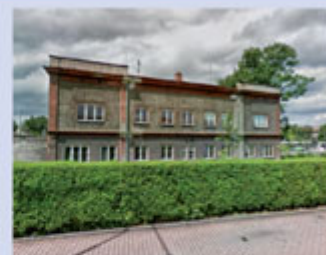
Budova na ul. Jablunkovská 837/8 v Českém Těšíně,
