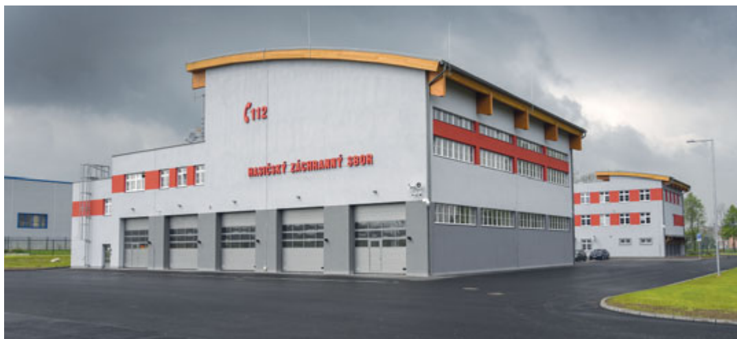
V areálu se nacházejí tři budovy, které na sebe navazují, ale také chodníky, komunikace a stání pro vozidla záchranných složek.
