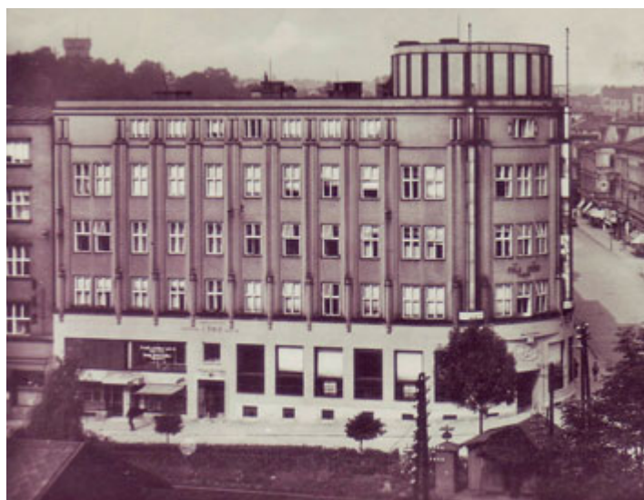
Pohled z restaurace „Slavoj“ (ul. Frýdecká 595/2) na budovu banky, která byla navržena v modernistickém slohu. Kolem roku 1937.
