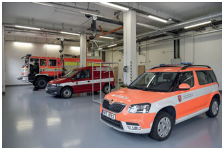
Nové garáže umožní dovybavení hasičů, do původních se nová technika nevešla.
