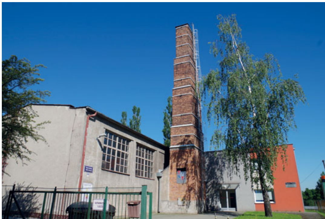
Sídlo společnosti Teplota Těšína, kde je také velín a jedna z kotlen. Těch má společnost celkem 33, většina z nich je řízena centrálně.
