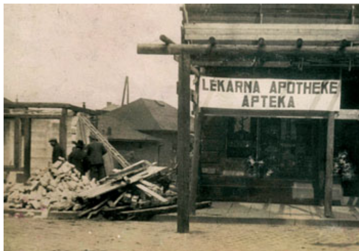
Pohled z Hlavní třídy na probíhající demolicí městských krámů. Napravo trojjazyčná reklama lékárny „U Salvatora“. Duben 1929. FOTO | SOUKROMÁ SBÍRKA CZESŁAWA KRAINY
