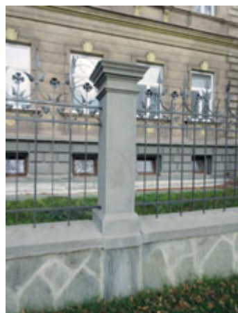
Plot po obnově
