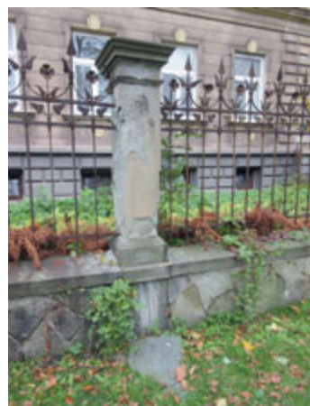
Plot před obnovou
