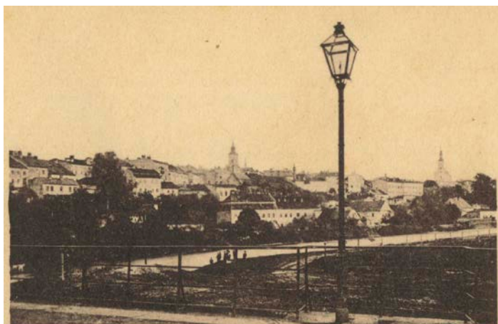
Pohled na pravobřežní Těšín v roce 1895 z nynější Hlavní třídy. Lampa na snímku je ještě plynová.
