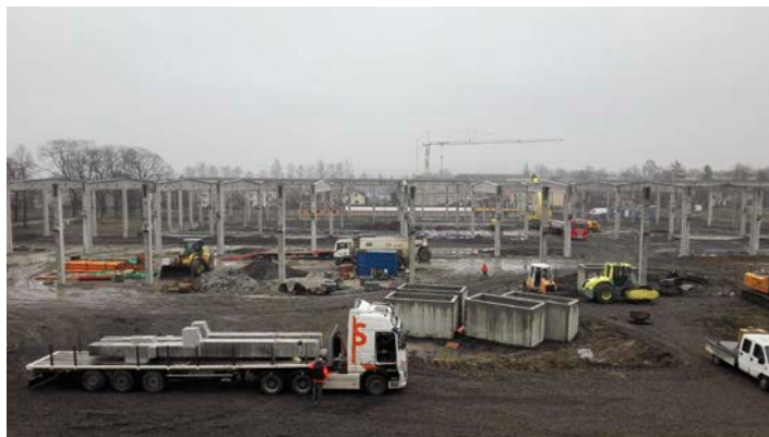
Základy nových hal rostou jako z vody.
