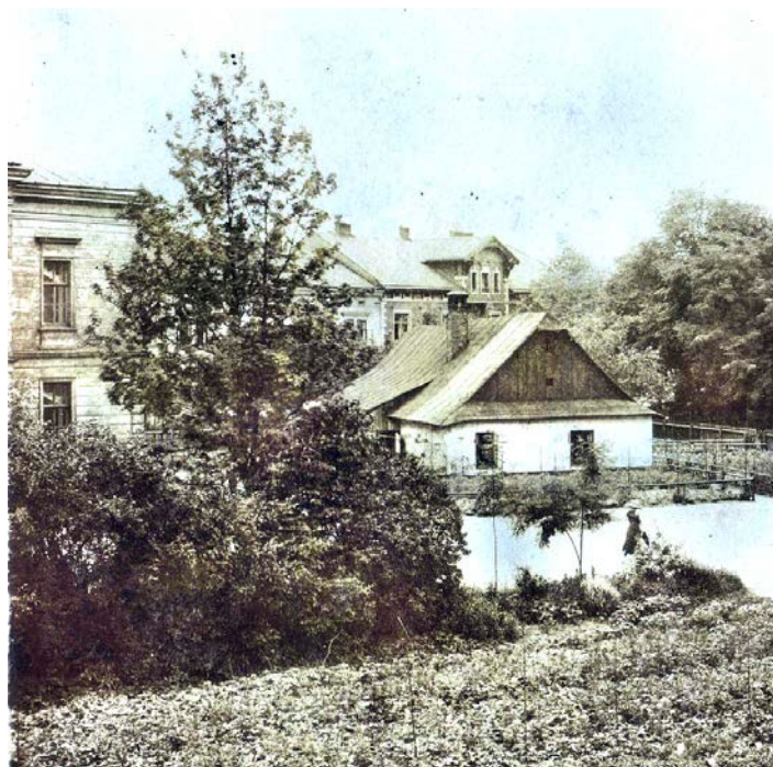
Pohled z prostoru nyníjšího školního nádvoří na dům Josefa Bernatzika, vlevo zadní průčelí ZUŠ Pavla Kalety. Kolem roku 1910.
