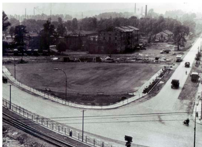
Bývalá Kohnova továrna v letech 1952-1953.
