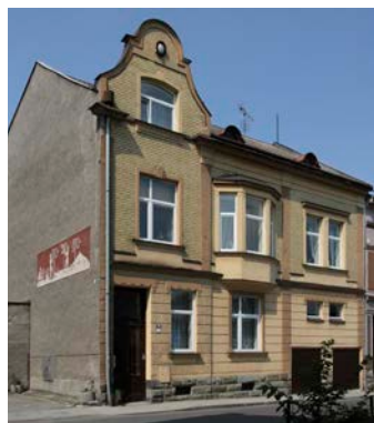
Současný pohled na dům Selmy Lach.
