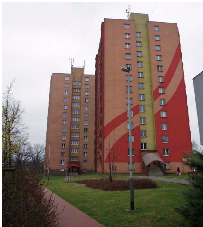
Zateplením popisovaného typu se změnil zejména vzhled atypických lodžii a je ztracena celková tektonika stavby.
