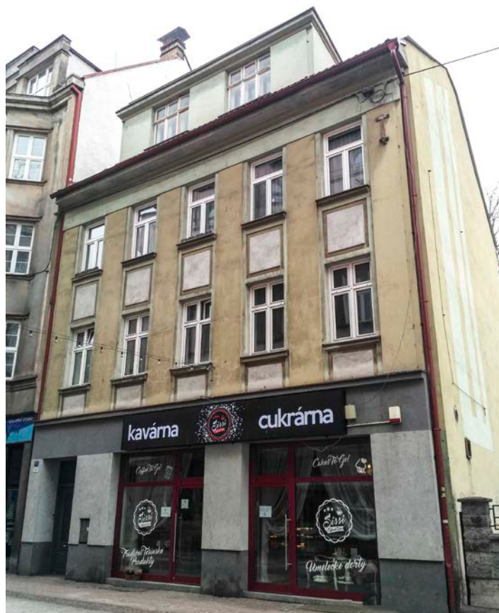
Současný pohled na dům Rudolfa Kotzura.
