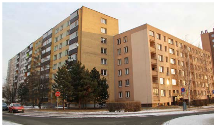
Levá strana snímku zachycuje typ T06B-BTS a pravá OP1.11 – jedná se tedy o zlom, ve kterém se změnil typ použité soustavy.
