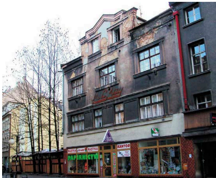
Dům Mosese Löbl Maye před rekonstrukcí v roce 2003.
