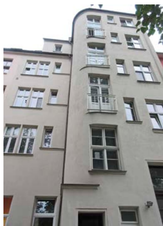
Obnova zadní fasády.
