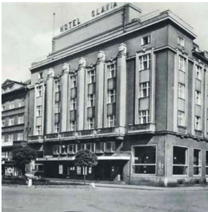
Pohlednice s hotelem Slavia pochází zřejmě z roku 1948. Nad vchodem do budovy je nápis Divadlo Těšínského Slezska.
