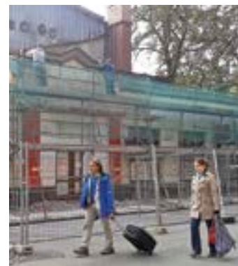
Budova kina nyní prochází celkovou rekonstrukcí. FOTO | DOROTA HAVLÍKOVÁ
