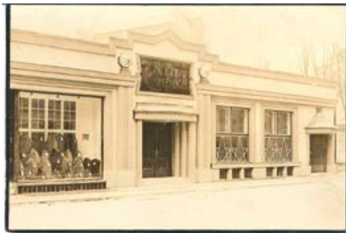
Rekonstrukce by měla kino uvést do původní podoby s kubistickými prvky.
