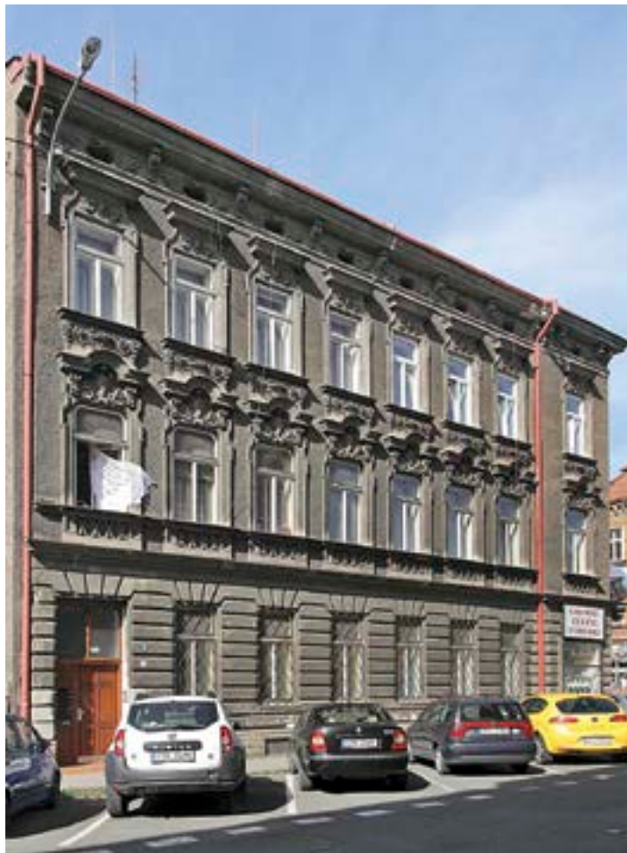
Současný pohled z ul. Božkovy na rohový dům Eduarda Seemanna.
