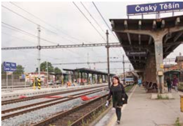
Nově vybudované perony mají kratší zastřešení.
