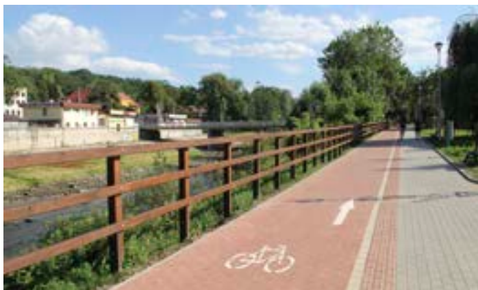
Nový úsek cyklostezky slouží rodinám od prvního července už i mezi hraničními mosty.
