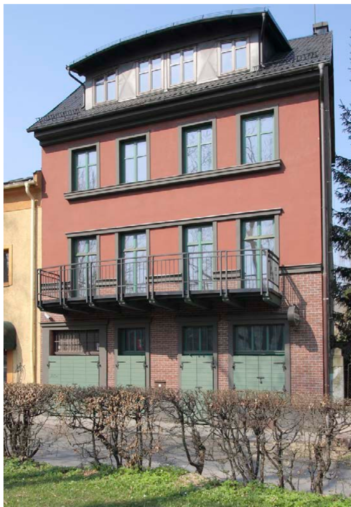
Současný pohled na dům rodiny Malinových.
