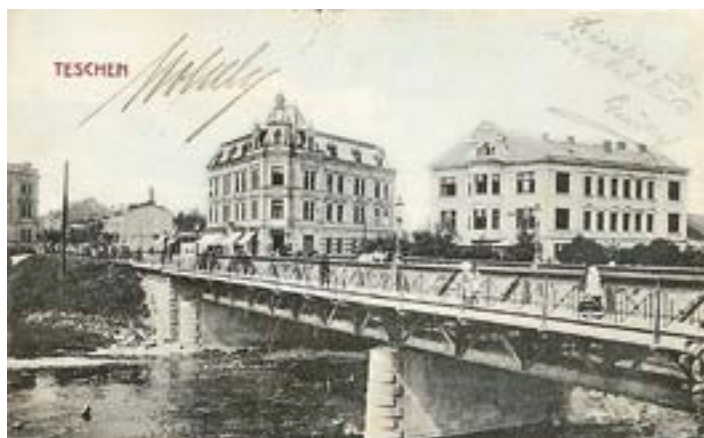
Pohled z pravého břehu kolem roku 1908 na nový ocelový příhradový most.
