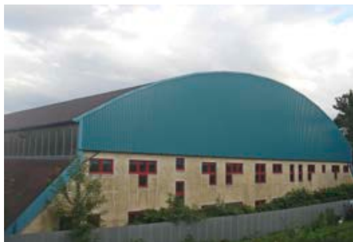
Takto vypadala původní budova stadionu před opravou.
