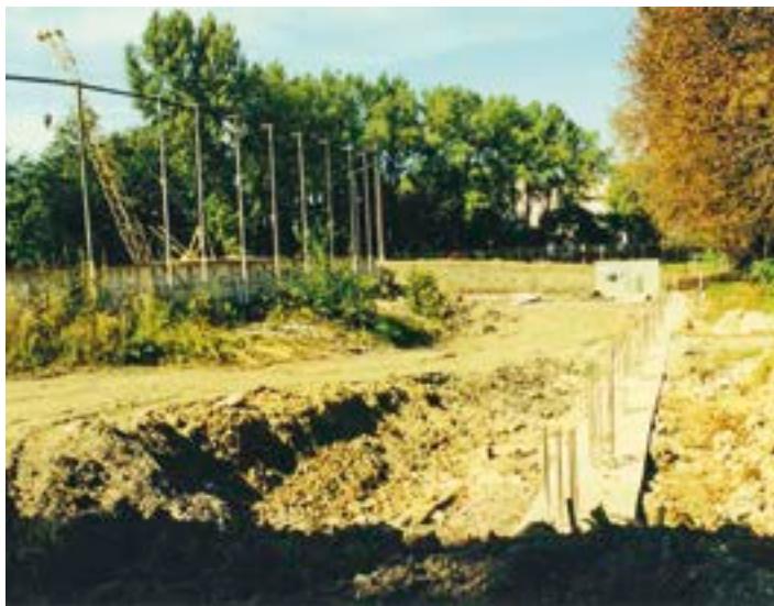
Fotografie z roku 2000, kdy se stavělo zastřešení stadionu.
