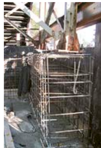
Proces betonáže základové patky mostku byl náročný zvláště proto, že stavbaři pracovali v sousedství potoka.
