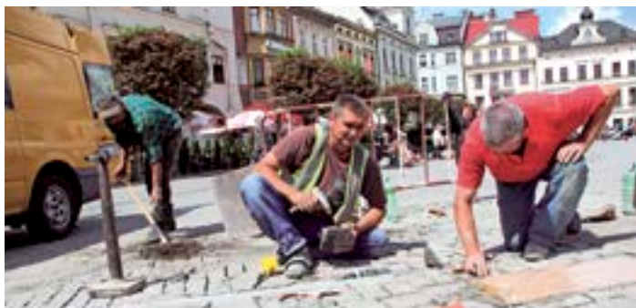
Mistři kameníci pokládají dlažbu mezi kolejnicemi tak, jak byla uložena před sto lety.
