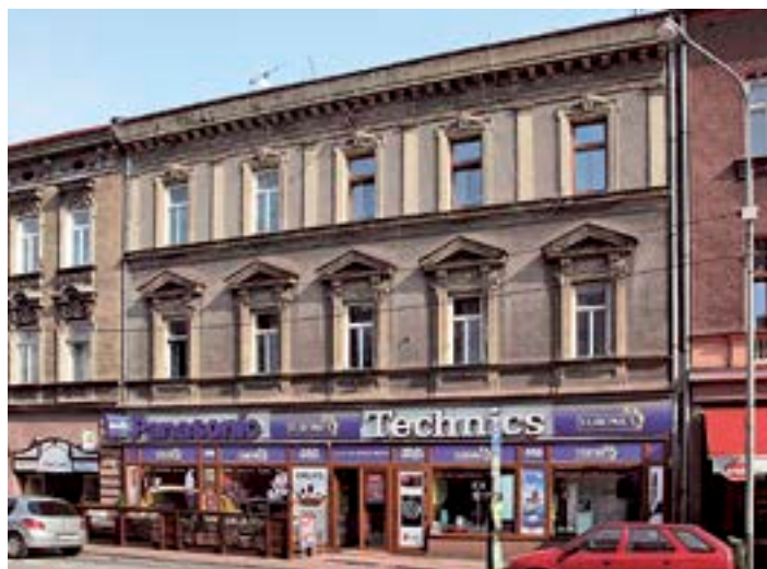
Současný pohled na dům Eduarda Seemanna.
