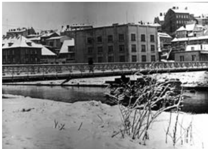
Lávka pro pěší na prodloužení ulice Moskevská.
