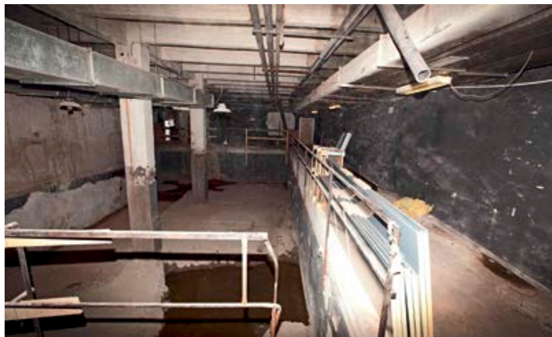
V kotelně vzniká nová scéna Těšínského divadla. Bude sloužit především loutkářům Bajky.
