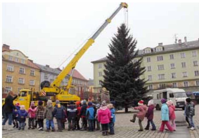
Instalace stromu na náměstí pomocí těžké techniky přitáhla řadu diváků.
